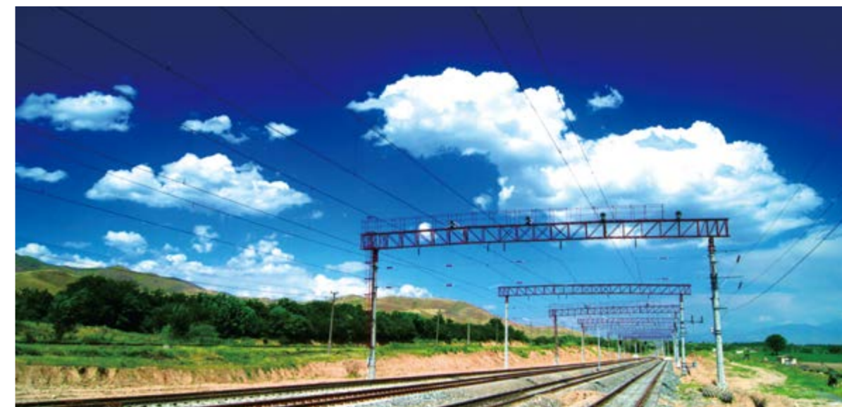
乌兹别克斯坦电气化铁路改造项目 The Railway Modernization Project in Uzbekistan
