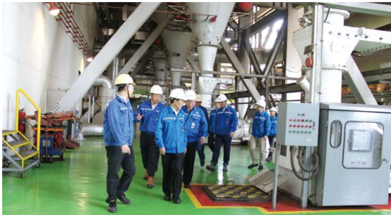
通用集团领导调研缅甸快速发电项目 Leaders of Genertec field-visiting the Myanmar LNG Fast Power Generation project
