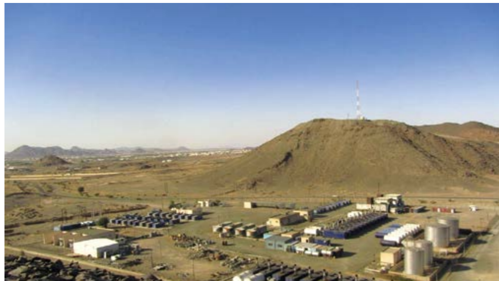
沙特 75MW 柴油机集群电站项目 The Saudi Arabian 75MW Diesel Engine Power Station Cluster project
